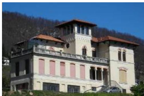
Sede della Comunità del Parco a Masone
